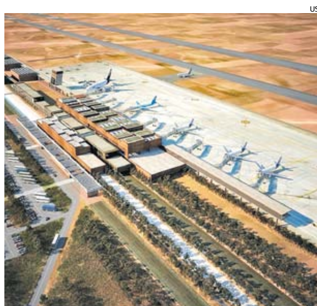
Las obras del aeropuerto iniciarán el 31 de enero próximo.
